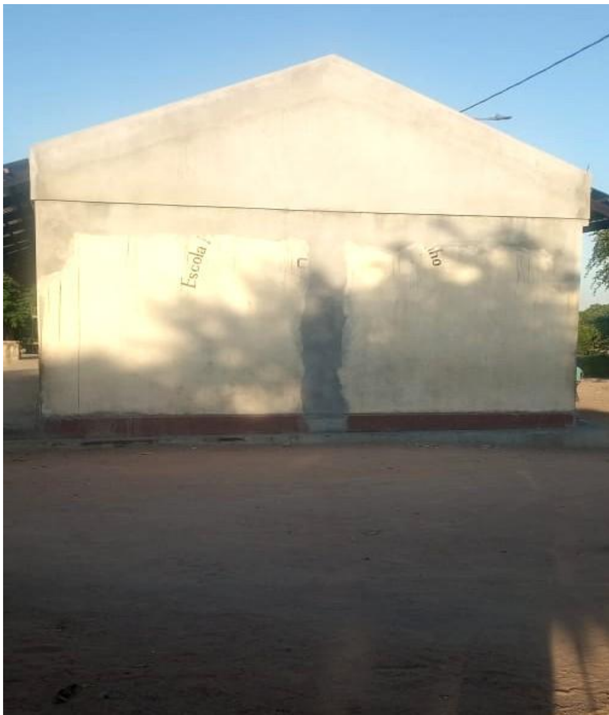
Figura 2: Vista frontal da Escola Básica 25 de Junho Ceta
